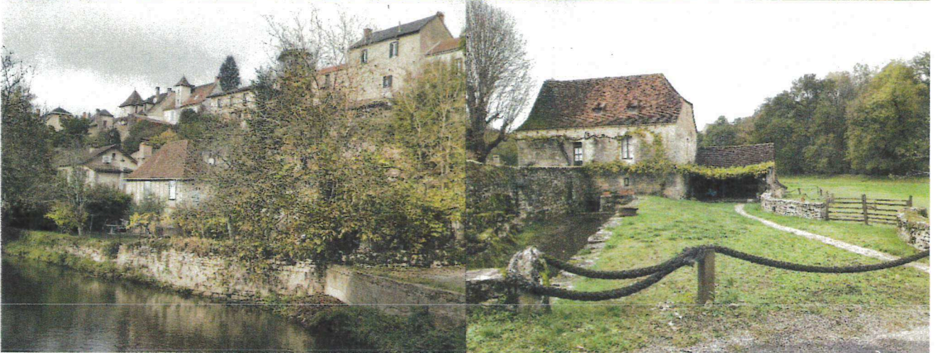
Diverses vues de la vallée de l'Alzou et ses moulins, en bas du versant sud du bourg. Photos UDAP46
