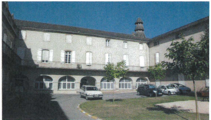
Cour de l'hôpital. Photo UDAP46.
