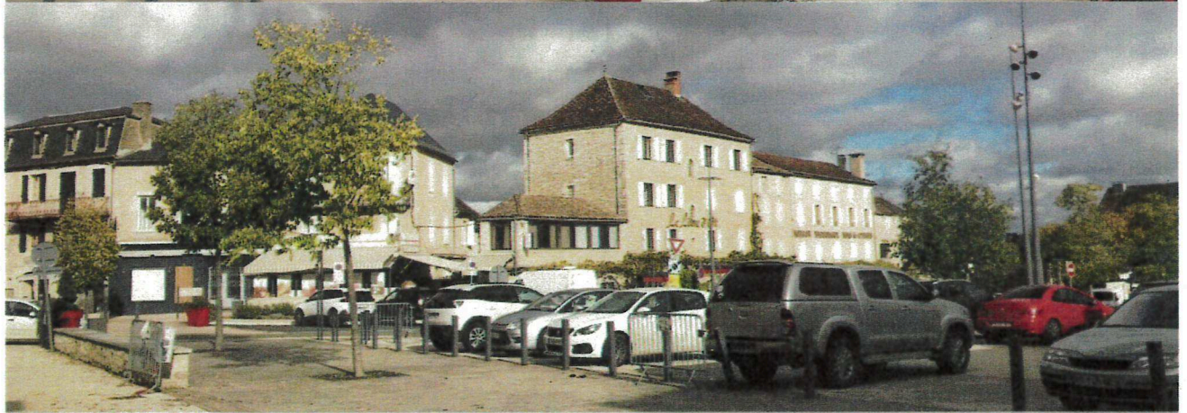
Les fronts bâtis de la place de la République en face desquels se positionne le monument. Photos UDAP46
